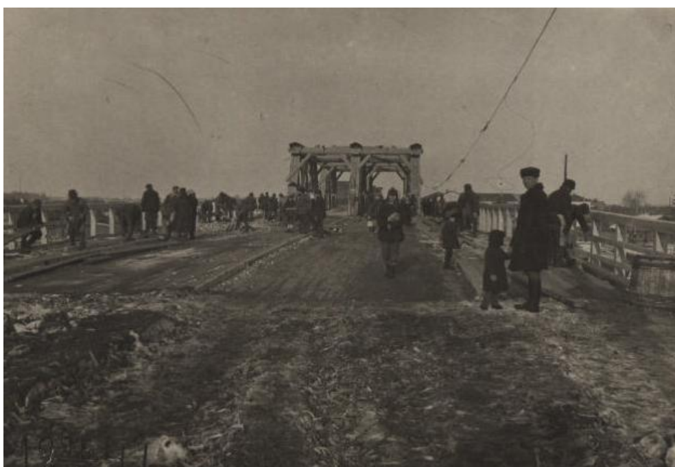
Фото 4. Строители Тюменского моста 1941 года
